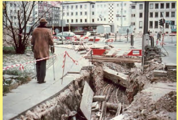
Einen deutlich höheren Schutz als das Warnband boten Kunststoffzäune, die später von Absperrgittern und Absperrschranken abgelöst wurden.
