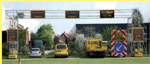
Mit den neuen mobilen Autobahnbrücken sind Fahrstreifen-Wechselanlagen (FSWA) möglich.
