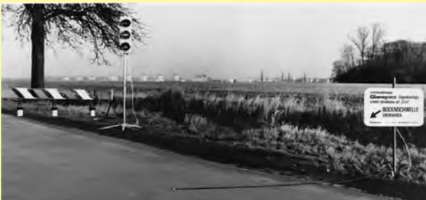
Erste verkehrsabhängige Signalanlage: Durch Überfahren der Bodenschwelle wird die Anforderung sowie Verlängerung von „grün“ ausgelöst.
