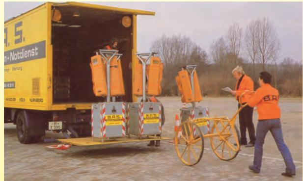
Der stets startbereit geladene LKW traf nach kürzester Zeit am Einsatzort ein. Die an großen Akkukästen befestigten Signalgeber wurden über eine Ladebühne vom LKW abgeladen und mit einer „Rikscha“ an den genauen Aufstellort gebracht. Die Aufbauzeit einschließlich Inbetriebnahme einer Kreuzungssignalanlage betrug nur ca. 2 Stunden. Die im Anhänger mitgeführten Ladestationen ermöglichten eine absolute Unabhängigkeit vom stationären Stromnetz.
