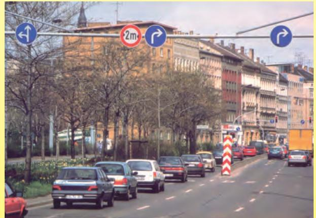
Die Über-Kopf-Kennzeichnung durch transportable Signalbrücken mit 13 m Spannweite ermöglicht z. B. im unübersichtlichen Stadtverkehr einen deutlichen Hinweis auf die Verkehrsführungen.
