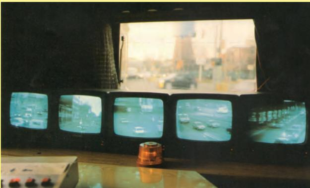
Mit dem Einsatz von Videokameras lassen sich unübersichtliche Verkehrsknoten mit mobilen Signalanlagen durch Handschaltung individuell steuern.
