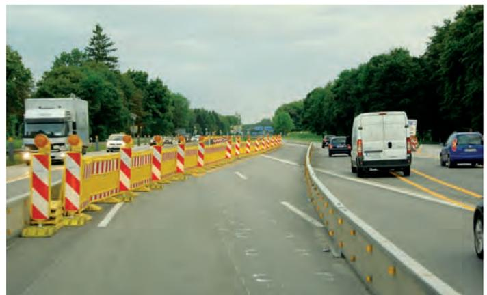
Bild 6: **Ausfahrt aus der Weiche(Süd) über MÜ in Richtungsfahrbahn** Der Verkehrsteilnehmer durchfährt diese Weiche (Baken und Zaun verhindern auch hier das „Falschfahren“) und wird über die MÜ auf die ursprüngliche Richtungsfahrbahn übergeleitet
