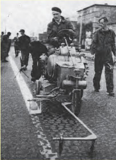
Die auf der Technischen Messe 1954 in Hannover vorgestellte neuartige selbstfahrende Markierungsmaschine ermöglichte maschinelle Markierungen.
