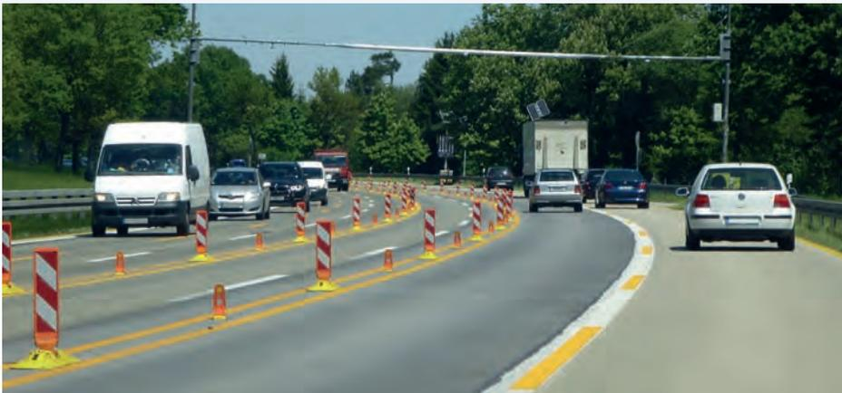
Bild 9: Detektorenbrücke
