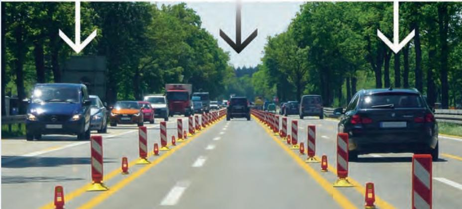
Bild 7: Wechselerkehrsführung unter Verkehr
