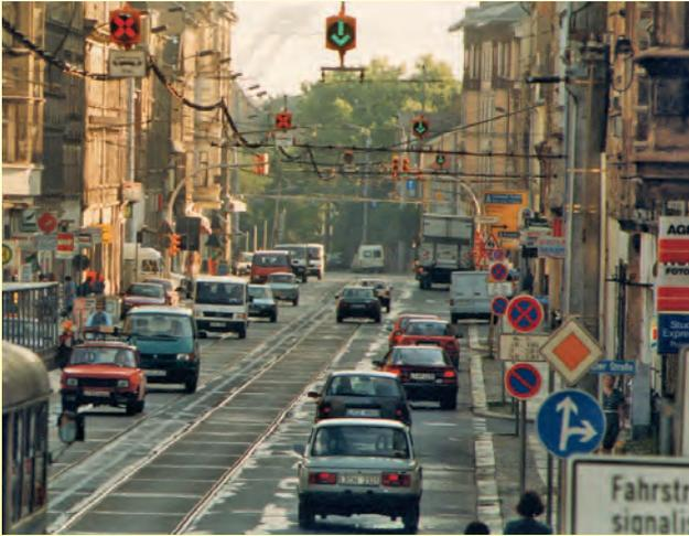
Die Straßenbahnen in Leipzig Richtung Grünau mit hunderttausend Einwohnern standen am Nachmittag derartig im Stau, dass zur Überbrückung der Verspätungen je Linie ein zusätzlicher Zug eingesetzt werden musste. Mit der neuartigen B.A.S.-Fahrstreifensignalisierung wurde nachmittags ein stadteinwärts führender Fahrstreifen gesperrt und für den Gegenverkehr freigegeben. Schlagartig gab es keine Staus mehr. Die im
