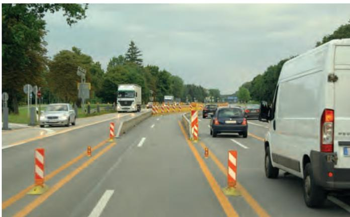
Bild 5: **Weiche (Süd) in FR GAP geöffnet zur Ausfahrt aus dem Wechselfahrstreifen.** Die Ausfahrt des Wechselfahrstreifens im Bereich der 2. Mittelstreifenüberfahrt wird wie bei der Einfahrt mit transportablen Schutz-einrichtungen im Bereich der Weiche abgegrenzt
