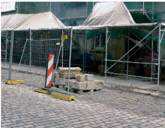
Bild 2: Unzureichend gesicherte Baustelle (Zitat: „In der Praxis tätige Personen müssen jedoch aktuelle Empfehlungen erhalten (Dresden 2009).“)
