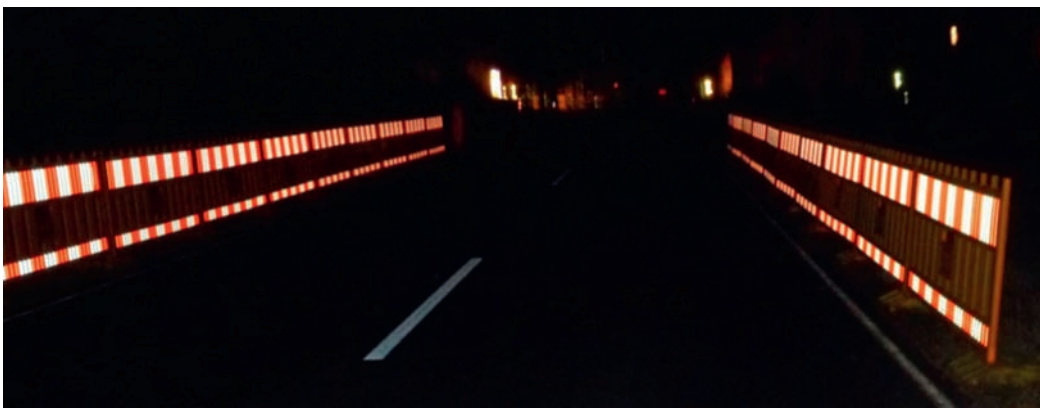
Bild 1: Nachtaufnahme des SLDS-Arbeitsstellenzauns (aus Info-Prospekt Firma B.A.S. „Die neue Generation“)
